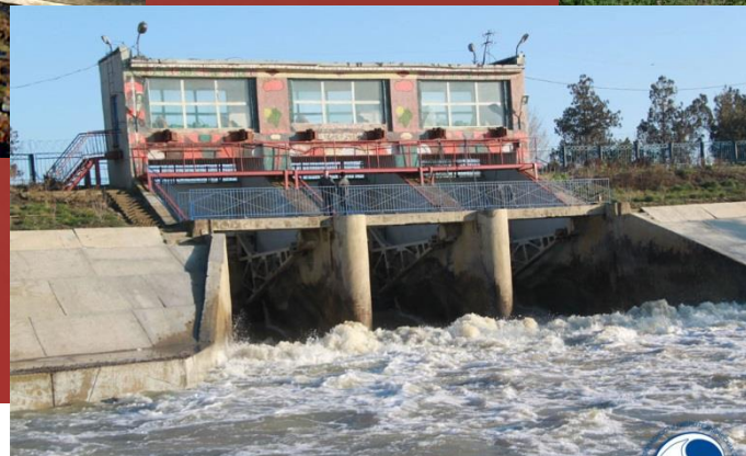
Водосбросное сооружение (со стороны нижнего бьефа)
