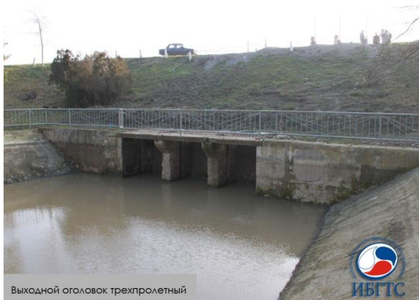
Выходной оголовок трехпролетный
